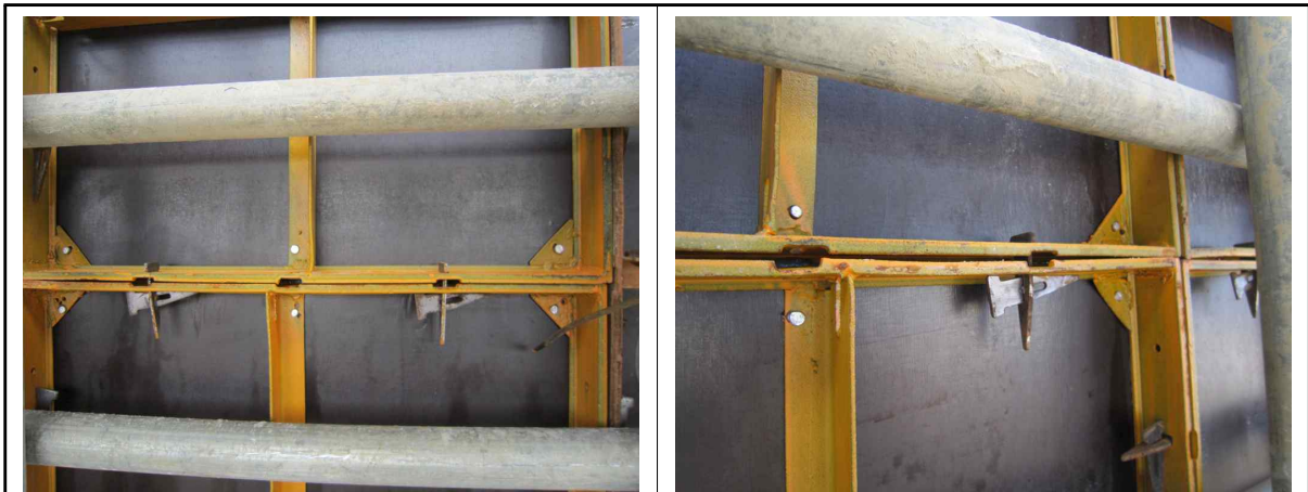
교량 A1 거푸집 체결 상태 현황
