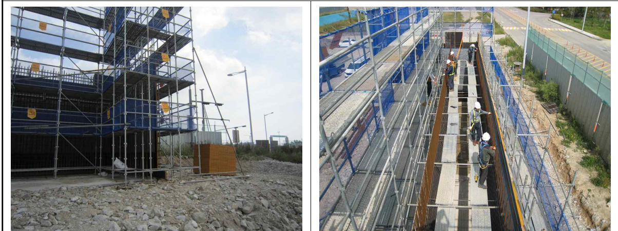
교량 A1 시스템동바리 설치 현황
