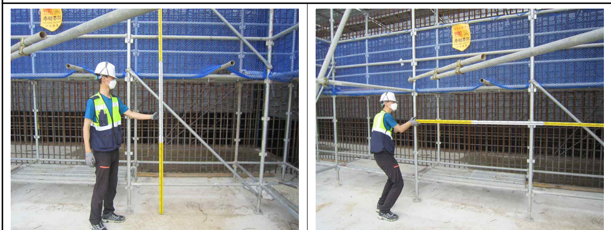
교량 A1 시스템동바리 수직재 및 수평재 간격측정 현황
