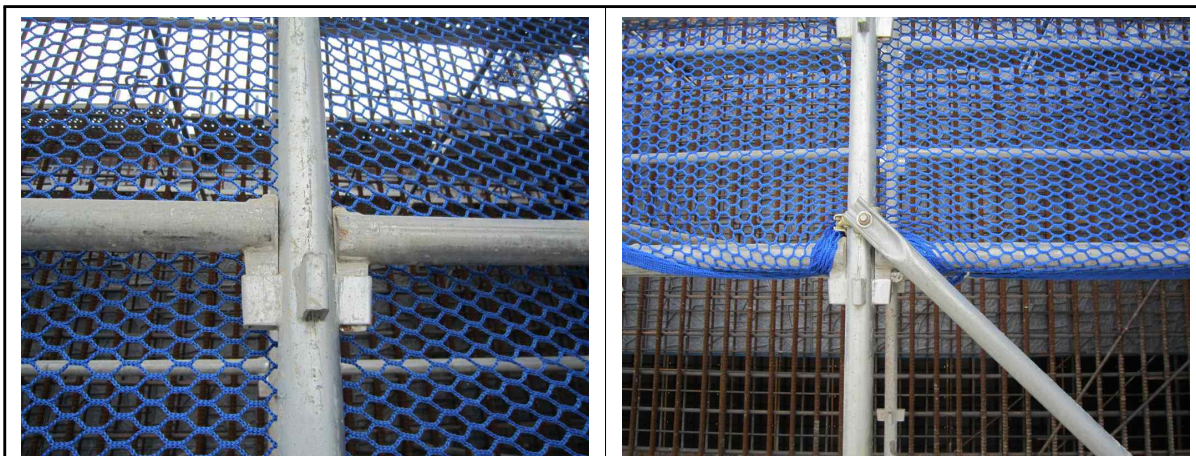
교량 A1 시스템동바리 수직재, 수평재 체결상태 현황
