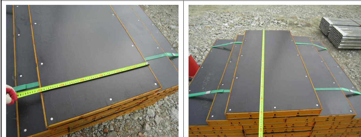
교량 A1 거푸집 자재 검수(600×1200)
