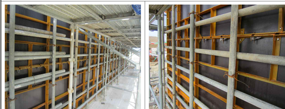
교량 A1 거푸집 설치 상태 현황
