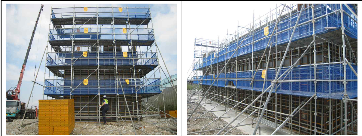
교량 A1 거푸집 설치
