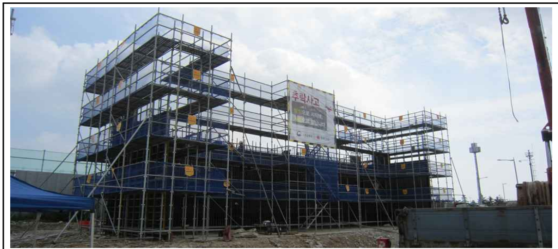
<교대 A1 전경>
