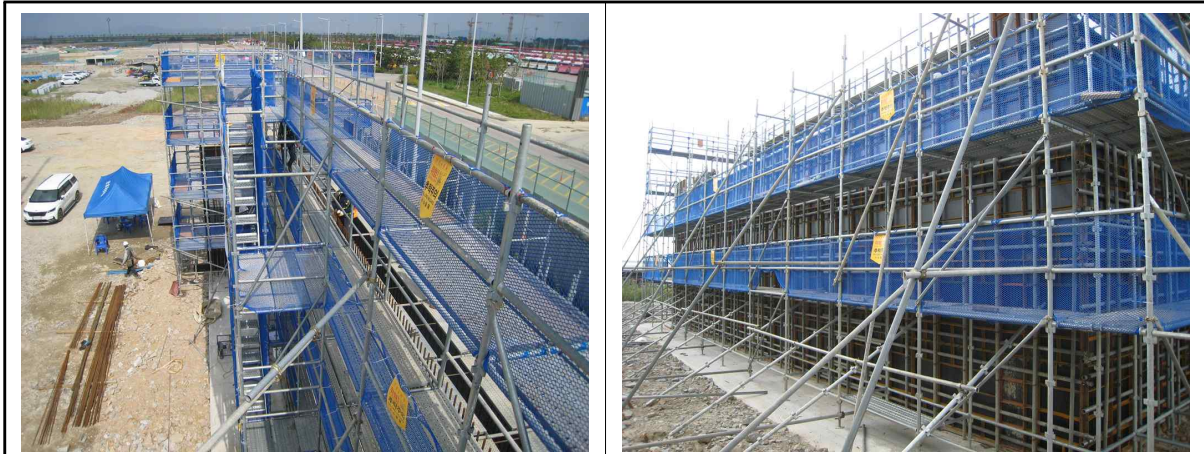
교량 A1 시스템동바리 설치
