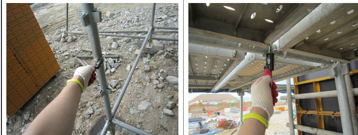
교량 A1 시스템동바리 수직재 및 수평재 직경측정 현황
