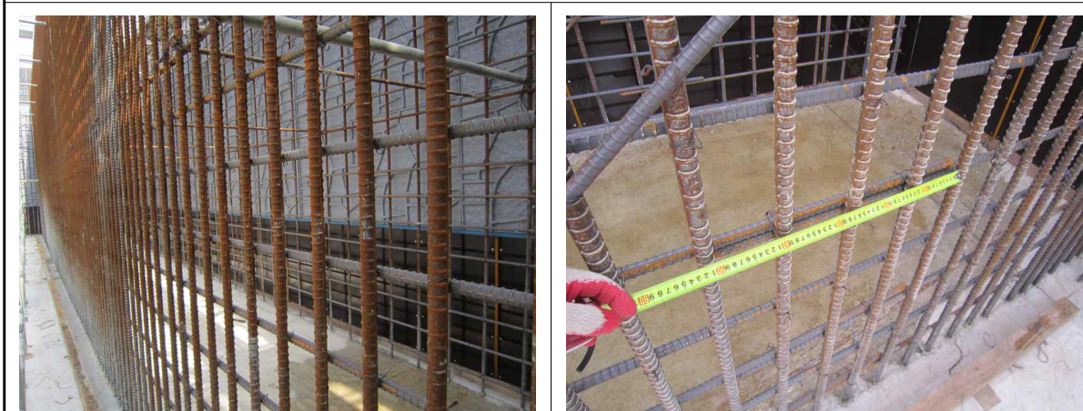
교량 A1 철근 배근 현황
