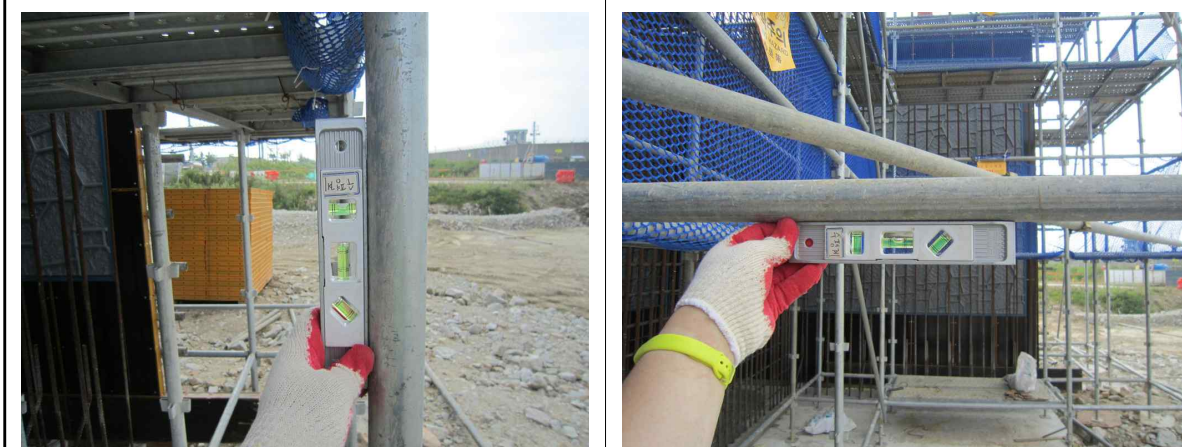
교량 A1 시스템동바리 수직재 및 수평재 수직, 수평도 측정 현황
