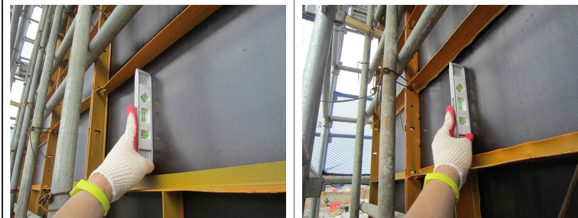
교량 A1 거푸집 수직도 측정 현황
